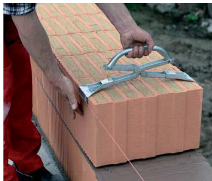
Obr.45. Pokládka zdiva za pomoci samosvorných kleští
