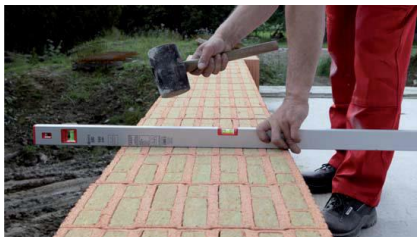
Obr.41. Konečné urovnání ve svislém a vodorovném směru
