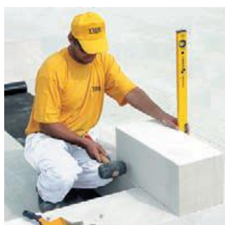
Obr. 18. Založení vnějšího rohu (systém Ytong)
