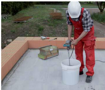
Obr.43. Příprava tenkovrstvé malty
