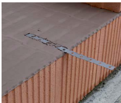
Obr.50. Vložení spony z nerezavějící oceli
