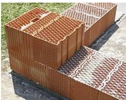
Obr. 15: Příklad založení vnějšího rohu
