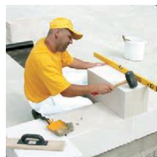
Obr. 20. Založení vnějšího rohu (systém Ytong)
