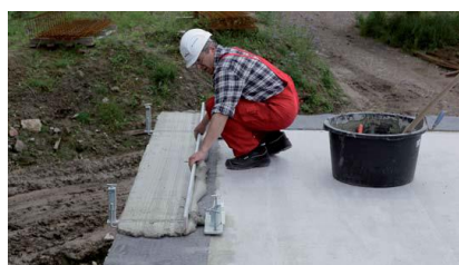
Obr.38. Stržení zakládací malty
