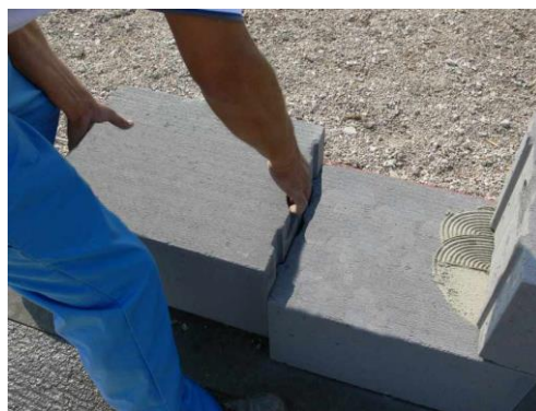
Obr. 23. Příklad zdění obvodové stěny
