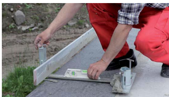
Obr.39. Přestavení zakládací soupravy
