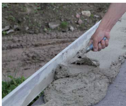
Obr.37. Rozprostření zakládací malty lžící
