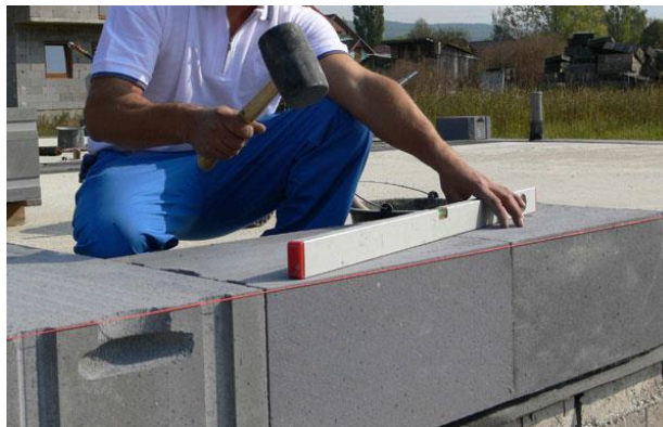
Obr.27. Ukázka zdění obvodových stěn z tvárnic Hebel
