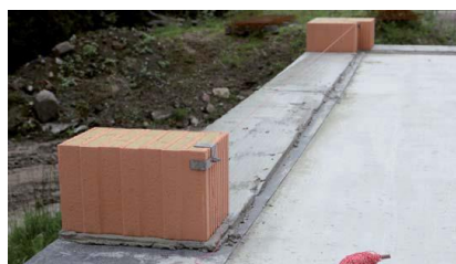
Obr.40. Začátek zakládání
