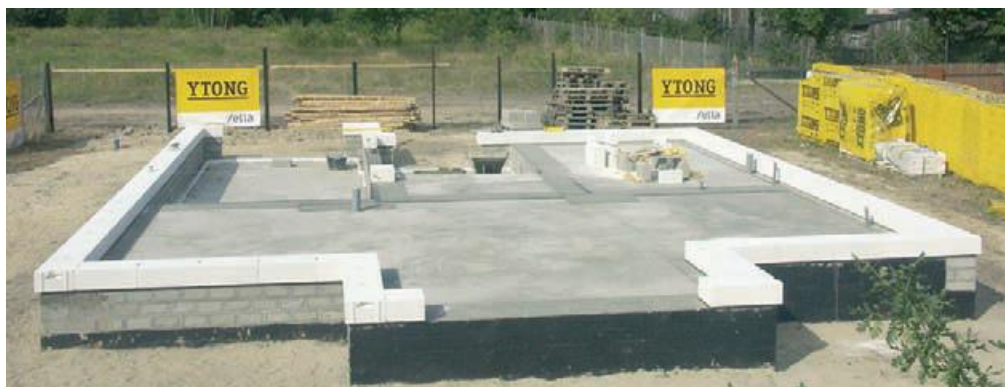
Obr. 17. Založení stavby (systém Ytong)
