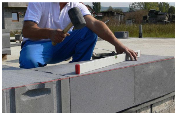
Obr. 22. Příklad zdění obvodové stěny
