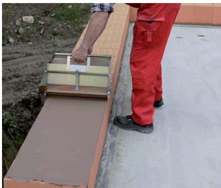
Obr.44. Nanesení tenkovrstvé malty za pomoci maltovacího vozíku
