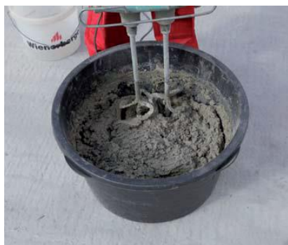
Obr. 35. Příprava zakládací směsi
