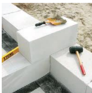
Obr. 19. Provázání vnitřní nosné stěny
