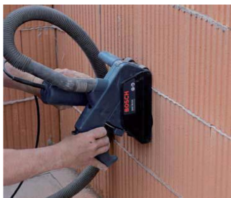
Obr.54. Drážkování drážkovací frézou
