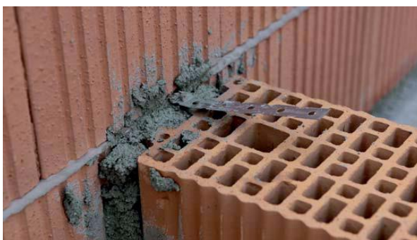
Obr.51. Provázání nosné stěny se stěnovou sponou
