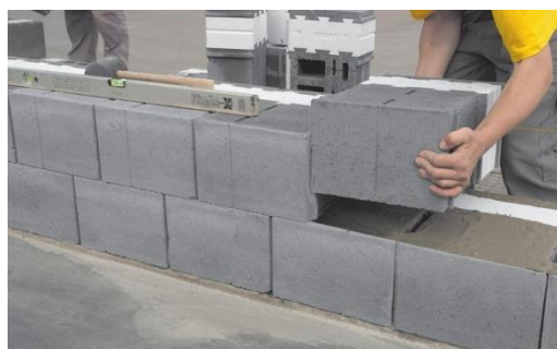
Obr.31. Obvodová zeď z dílce Super IZO
